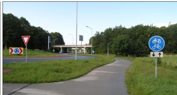
Groningerstraat met rotonde en viaduct A28 gezien richting het westen
